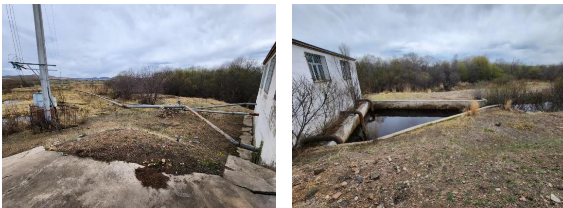
图 4-1-1 2013 年恩和乡农业综合开发项目建立的泵站现已无法使用
